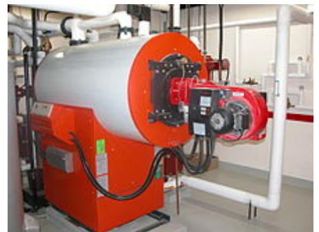
Caldaia a condensazione
